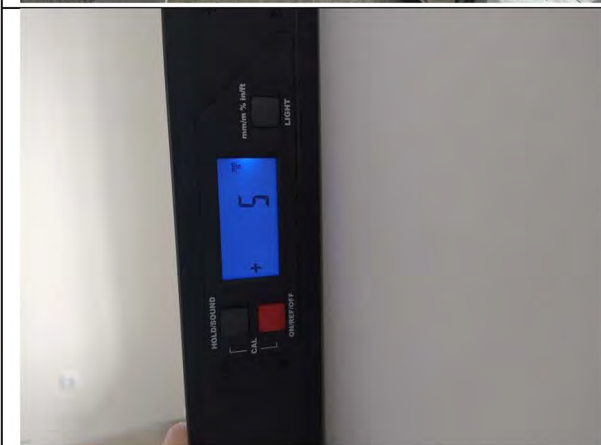
Фото №9. Измерения уровня стен в спальне.
